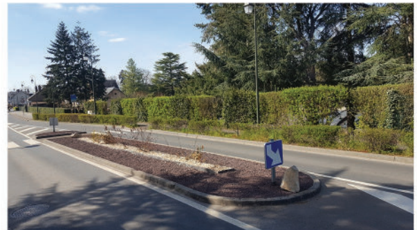
Terre plein rue de Gardais aménagé avec de la pouzzolane rouge à la place du gravier gris
