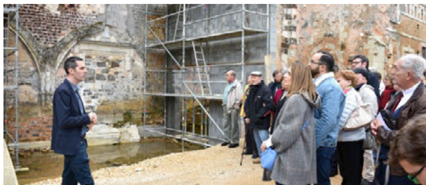
Sur le site, les travaux ont repris en septembre.
